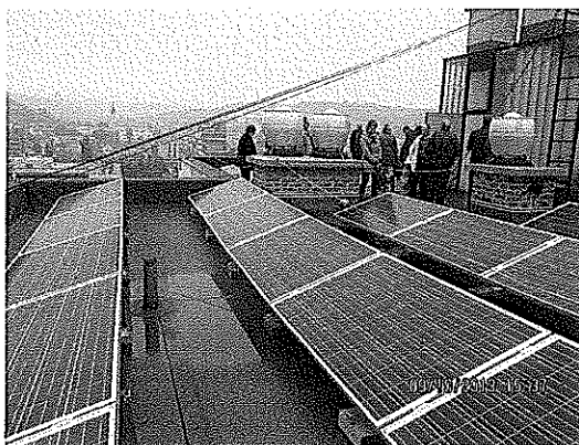
Társasházak közösségi villamos energia felhasználásának kiváltása napelemekkel, bemutató Szekszárd, Mészáros L. u. 3. 2013.10.09
