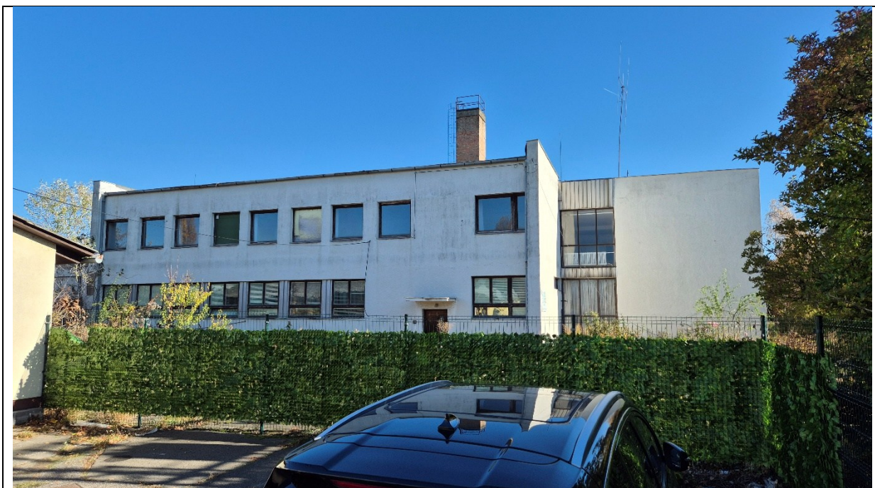
Egykori irodaépület volt iskolaépület a hrsz 01611/7 teleken nyugati oldal
