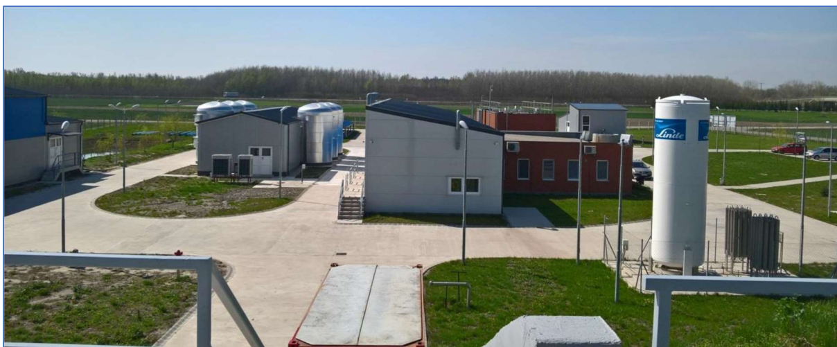
65. ábra: A 2015-ben átadott Bogyiszlói vízműtelep 66
