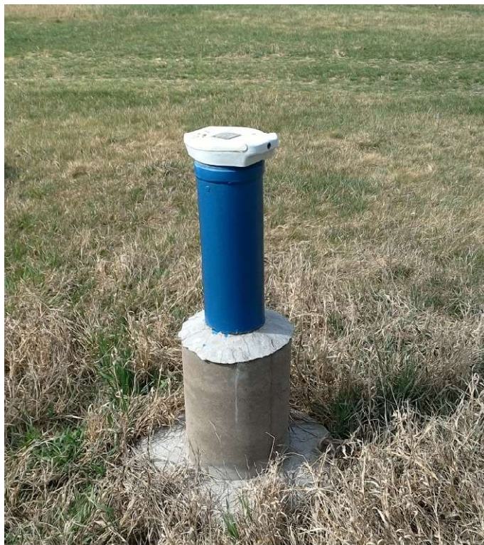
29. ábra: Jellemző kútfej kialakítás a monitoring kutak esetében
