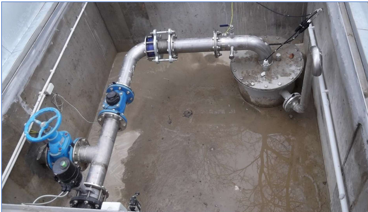
64. ábra: A kútfej kialakítása 65
