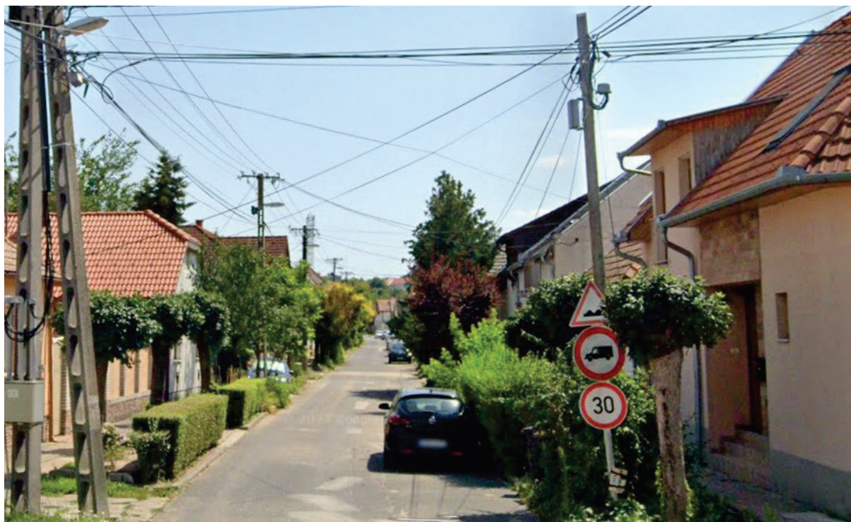
30. ábra: Kossuth L. u. csapadékvíz előntéssel érintett szakasza
