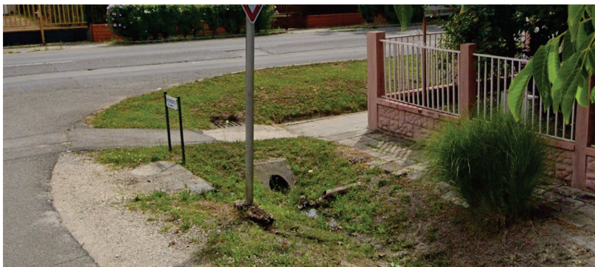
25. ábra: Nyílt árok bevezetési pontja a zárt rendszerbe a Mattioni u. és a Szent-Györgyi Albert utca találkozásánál
