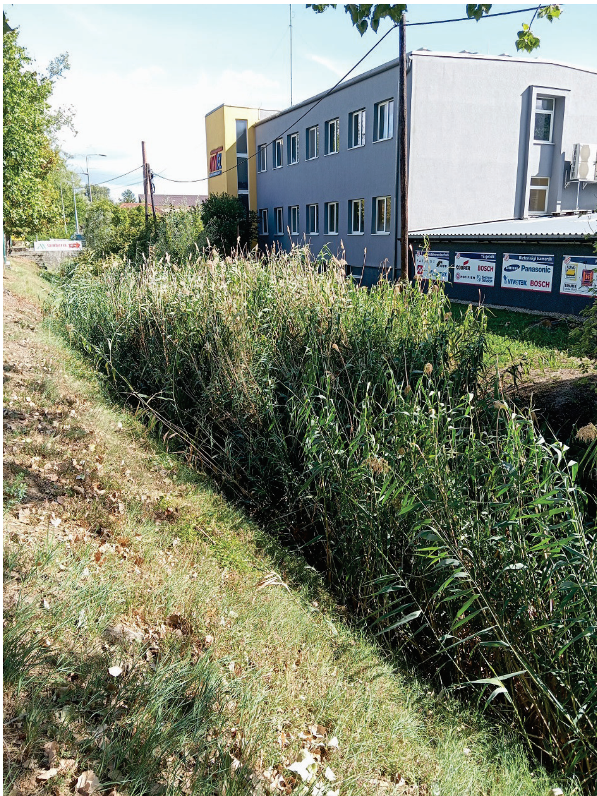
32. ábra: Keselyűsi úti árok benövényesedett medre
