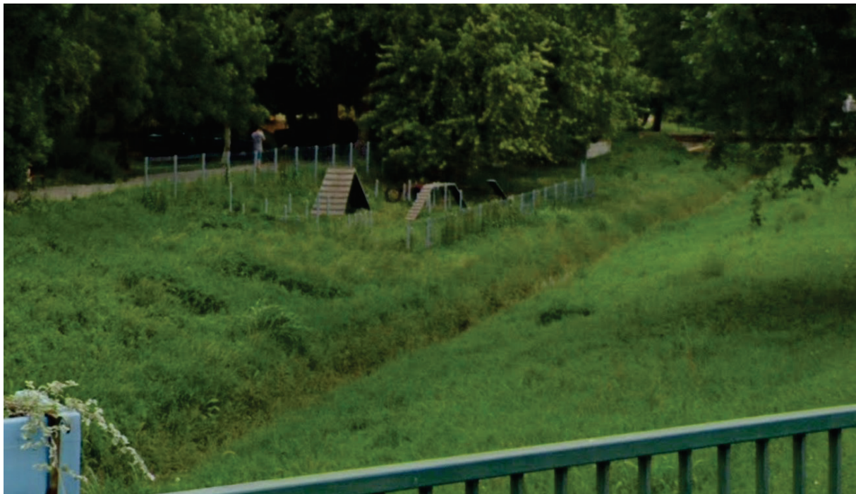
34. ábra: Kutya futtató kerítéssel a Szekszárdi-Séd nagyvízi medrében (buszpályaudvar mellett)
