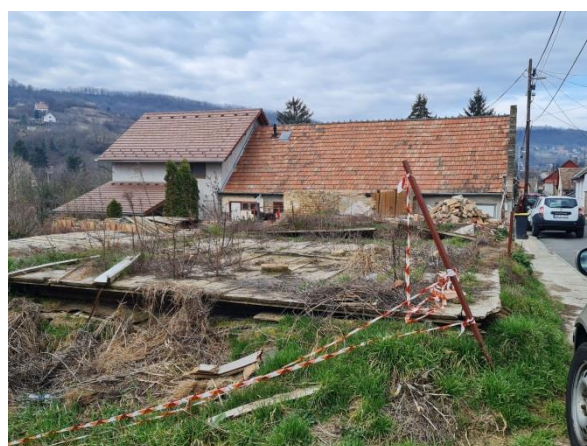
A telken elbontott épület alapfalai
