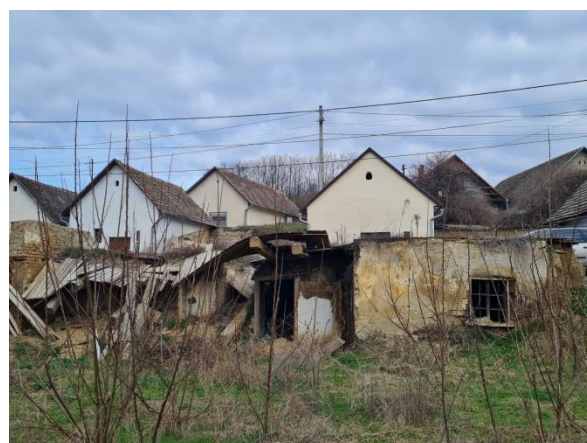
Az elbontott épület dél felől nézve
