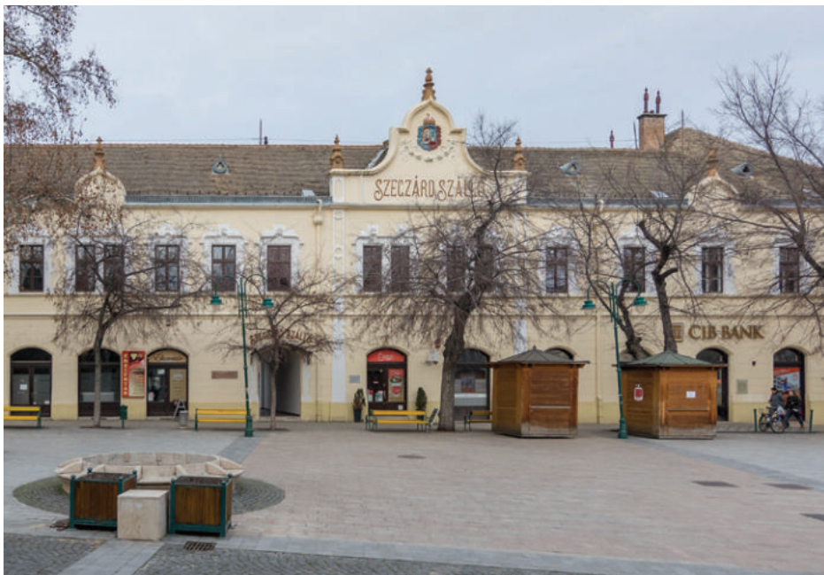
Garay Szálló (Szegezsárd Szálló) Garay tér 2.
