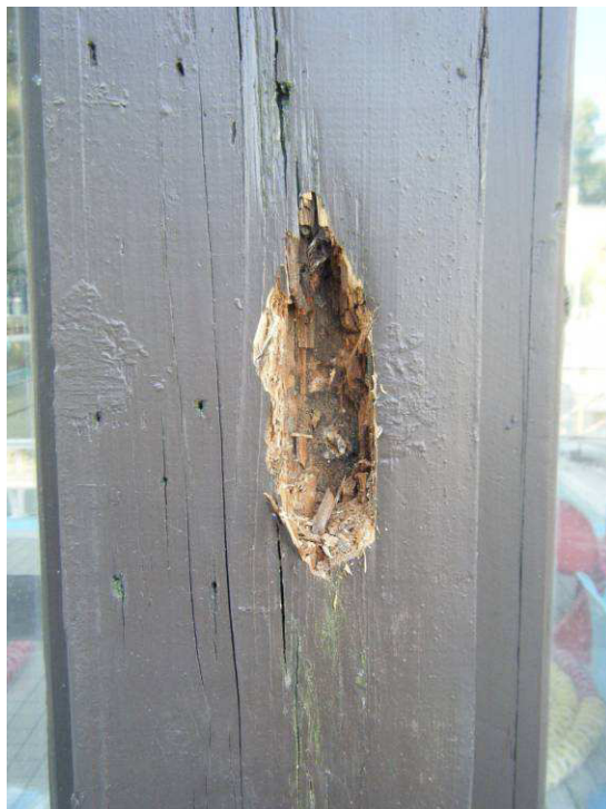
6. sz. kép : a végfali oszlop kb. 3-4 cm mélyen korhadt és kb. 1-2 cm mélyen repedt
