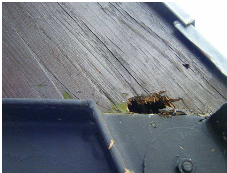
4. sz. kép : a keret alsó vége a felső csavar felett kb. 4-5 cm mélyen korhadt
