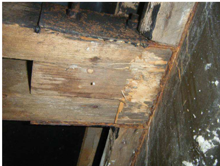
2. sz. kép : a szelemen vége kb. 1-2 cm mélyen korhadt
