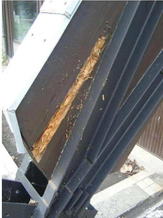
1. sz. kép : a keret alsó vége kb. 60 cm hosszan kb. 3-4 cm mélyen korhadt és kb. 2-3 cm mélyen repedt
