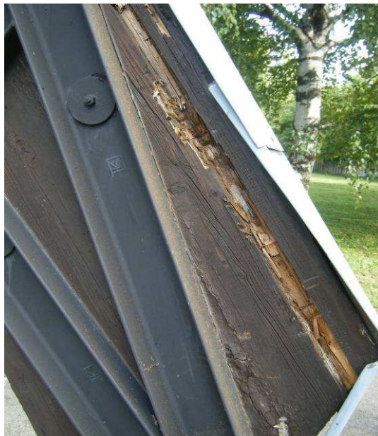
2. sz. kép : a keret alsó vége kb. 1,5 m hosszan kb. 5-6 cm mélyen korhadt és teljesen elrepedt
