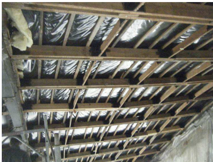
3. sz. kép : a szelemenek közel 20 cm-es alakváltozást szenvedtek
