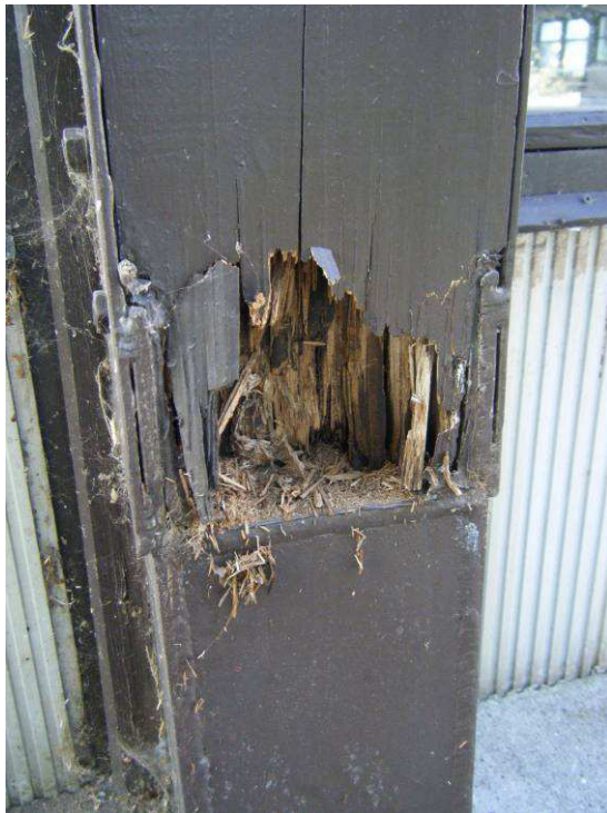
5. sz. kép : a végfali oszlop alsó vége kb. 6-8 cm mélyen korhadt, az oszlop kb. 2-3 cm mélyen repedt
