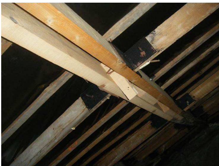
4. sz. kép : a szelemenek közel 20 cm-es alakváltozást szenvedtek
