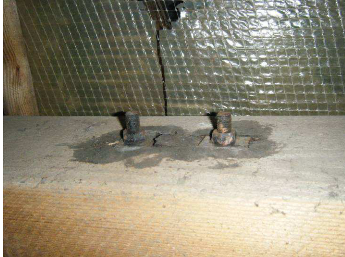
10. sz. kép : az alátétek benyomódtak a faanyagba
